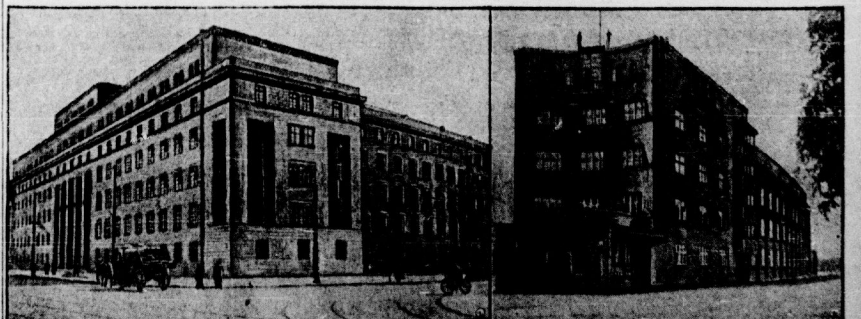
Die Bourgeoisie baut ihren Machtapparat gegen die Arbeiterklasse immer mehr aus. Das linke Bild zeigt das neue Polizeigebäude in Breslau. Dafür hat die „demokratische“ Republik Geld übrig. Trotzdem hat die Breslauer Kriminalpolizei die vielen Verbrechen, die in den letzten Jahren dort passierten, bis heute nicht aufgeklärt. — Die rechte Aufnahme zeigt einen Zeitungsenzian in Gelsenburg (Ostpreußen). Die österreichische Bourgeoisie arbeitet mit Hochdruck, um die proletarischen Massen unter ihren politischen Einfluß zu bringen.
