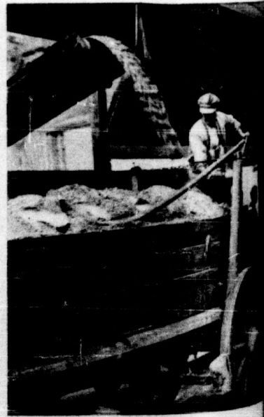
Fließband in der Baugrube
