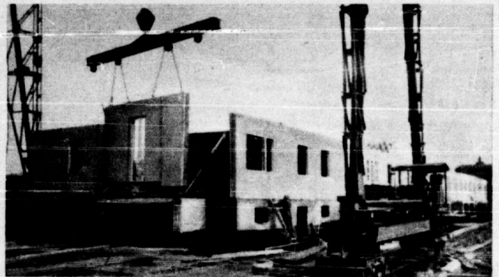
Hausbau in zwei Tagen
