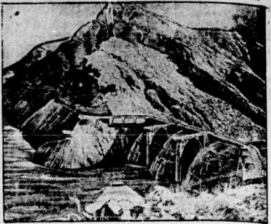
Im amerikanischen Staate Arizona wurde ein Stauwerk in Dienst gestellt, das aus vielen kugelförmigen Pfeilern konstruiert ist. Das Stauwerk ist mit einem Kostenaufwand von 22 Millionen Dollar errichtet und nimmt die Wassermengen des Carles- und Gils-Flusses auf.
