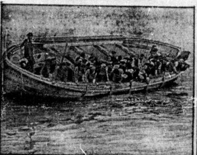
Um die Sicherheit im Schiffsverkehr zu heben, wird ständig an der Verbesserung der Rettungsbootsmöglichkeiten gearbeitet. So befinden sich jetzt auf dem Lloyd-Dampfer „Bremen“ Rettungsboote, die selbst durch die größte einseitige Belastung nicht kentern können. Unser Bild zeigt solch eine Probe, bei der 40 Personen ohne Erfolg versuchten, das Boot zum Umkippen zu bringen. Sollte es aber einmal trotzdem umschlagen, so richtet es sich selbst wieder auf.
