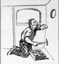
Sammer ift am Ende gespalten und magnetifiert. Die Ra muffen in den Mund genommen werden und die Zunge des Ar-beiters muß einen Nagel immer mit dem Kopf nach vorn zwischer die Lippen ichieben. Dann wird die magnetische Spige des Hams mers an die Lippen gesührt, der Nagel bleibt hängen und fann, ohne daß der Nagel mit der Hand berührt wird, eingeschlagen
