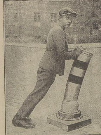
In München hat man neuerdings probeweise Verkehrsposten aus Gummi eingeführt, wodurch Verkehrsunfälle vermieden werden sollen. Wie unser Bild andeutet, bestehen diese Verkehrsposten aus äußerst elastischem Vollgummi, wodurch sie in der Lage sind, jede „Anremplung“ sanft, aber bestimmt zurückzuweichen. Also — bei mir prallte ab.
