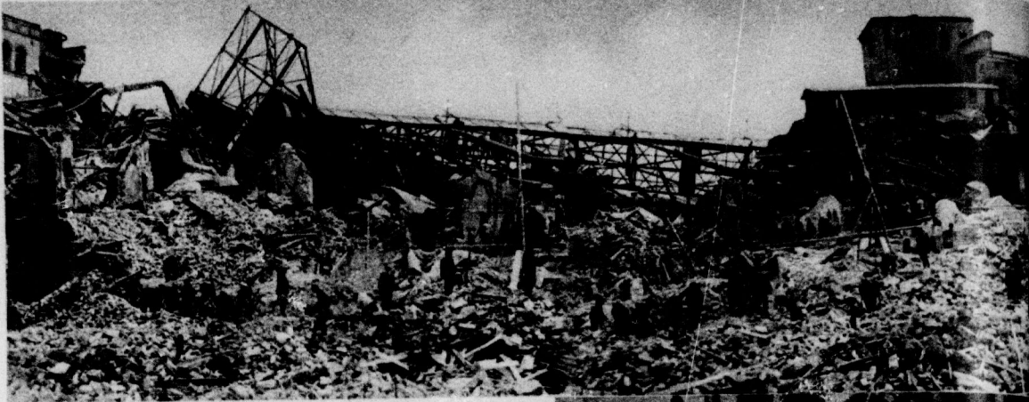
Das zerstörte Verwaltungsgebäude mit dem umgestürzten Förderturm des Schachtes „Anna II“
