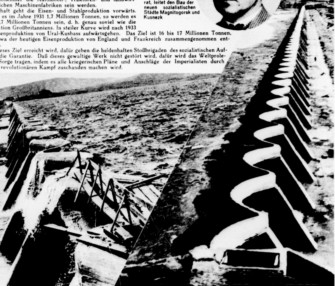
Ein Teil des Staudammes von Magnitogorsk. Sein Bau war eine Spitzenleistung der Udarniki (Stoßbrigaden)
