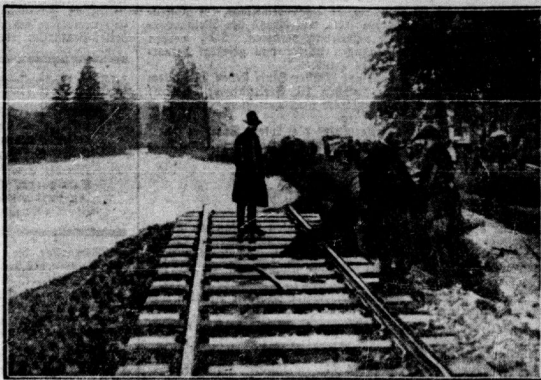
Wie hier im Harz, so überall unterspülte Bahndämme.
