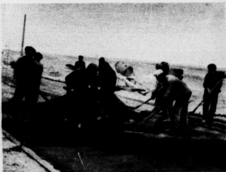
Asphalt-Chaussee im Neubau — mitten durch die Steppe
