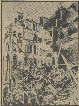
won Lyon, wo zwei Mietkasernen eingestürzt sind und unter ihren Trümmern Dutzende Menschen begraben haben.
