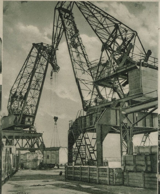
Ein neuer Schwerlasten-Wippkran am Hamburg-Alttoner Rußlandkai
