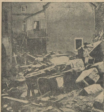
Die Trümmer der niedergedrissenen Häuser
