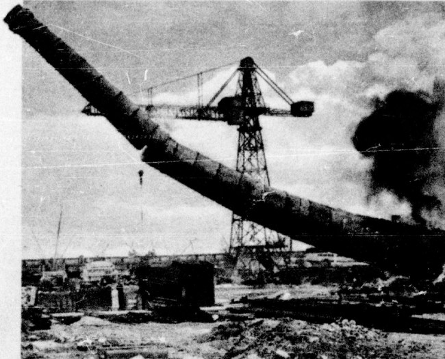
... es bildete sich der zweite Bruch. Unten: Der vierte Bruch, kurz vor dem Aufschlag
