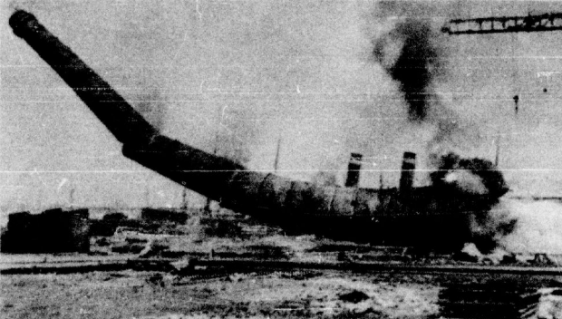
... es bildete sich der zweite Bruch. Unten: Der vierte Bruch, kurz vor dem Aufschlag
