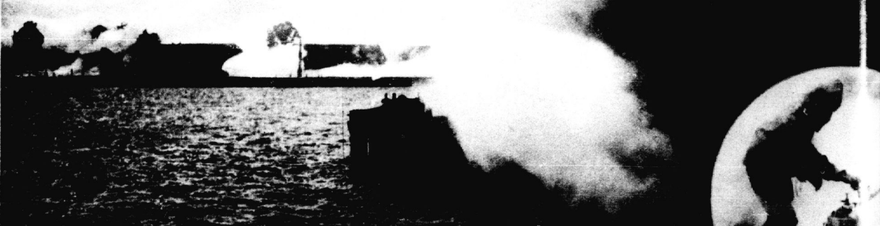
Das Elektrokraftwerk Friedland wird eingenebelt — Rechts: Die Nebelspritze
