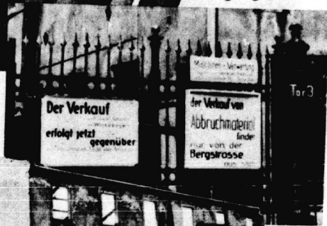
116 Gebäude und 22 Schornsteine der Hartmann-Werke werden umgelegt
