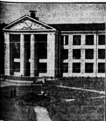
Iwanowo Wosnessensk. Unser Bild zeigt die Universität Chemie in einem Gebäude, das nach der Oktober-Revolution gebaut wurde
