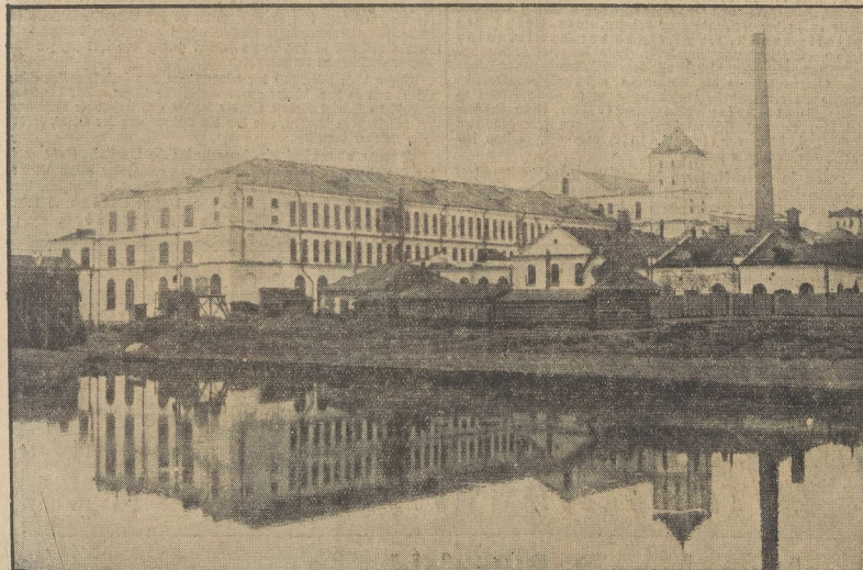
Die Tuchfabrik von Aramil, die jetzt erweitert wird, und daneben ein Neubau
