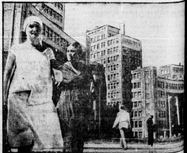
Der Bau ist vollendet
