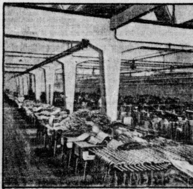
Blick in den Sortierraum der Kunstseidefabrik
