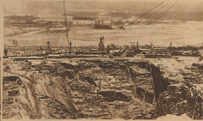
Links: Anlegen der Sprenglöcher unterhalb der Gesteins- massen, die gebrochen werden sollen
