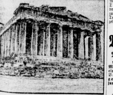
Die Utropolis wird repariert
