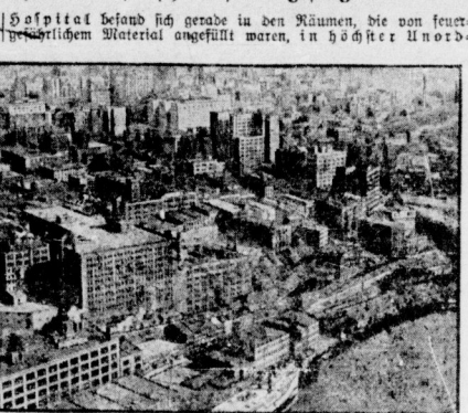
Die Stadt zeigt die von der Katastrophe betroffene Stadt, die im State Hotel ist und fast eine Million Einwohner hat. Der Brand des Krankenhauses hat sich auf die umliegenden Häuser ausgedehnt, was die Zahl der Todesopfer auf 125 gestiegen ist.
