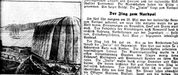
Mobiles Luftschiffhalle in Spitzbergen
