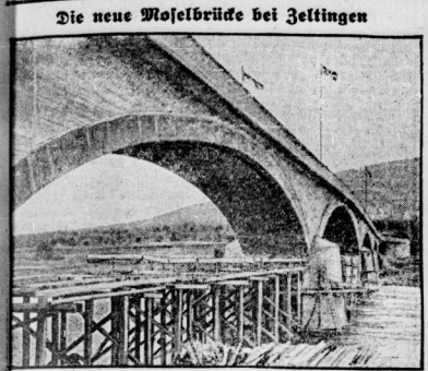
Die neue Moselbrücke bei Zelllingen
