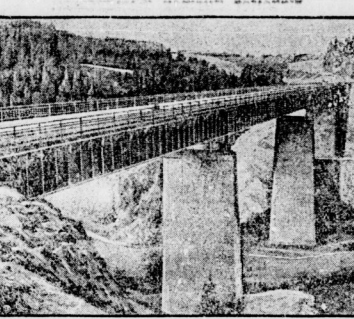
Vom Bau der großen Saalekaltperre Die Saalekaltperre am Westoß, in der Gegend von Saalfeld, deren Bau alljährlich vorwärts drückt, wird nicht nur die größte, sondern auch eine der schönsten Talperren Europas. — Unser Bild zeigt den neuen Wettera-Abzweiger, der über das Talperrengebiet führt.
