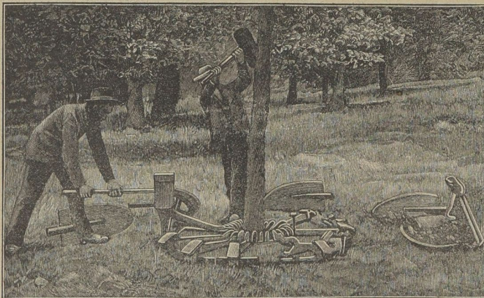
Eintreiben des Stahlkorbes zum Ausheben der Bäume. (Siehe obenstehenden Artikel.)
