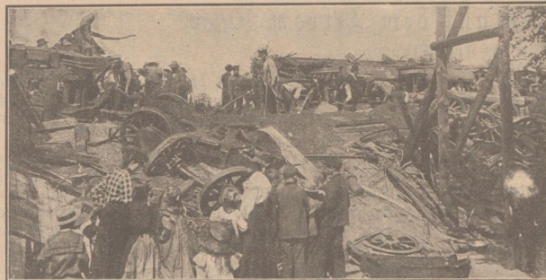
Copyright Berliner Illustrations-Gesellschaft. Bei den Aufräumungsarbeiten.
