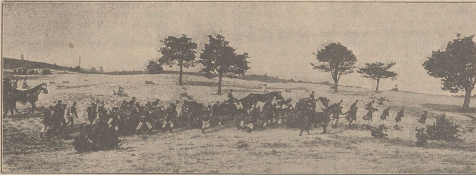
Der Weitertransport des gefüllten, bestiegene und 300 Meter emporgelassenen Luftballons in sandigem Terrain durch den von 6 Pferden und Mannschaften gezogenen Kabelwagen.
