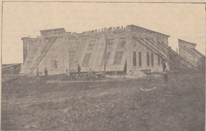
Das Haus einige Stunden vor der Fertigstellung.
