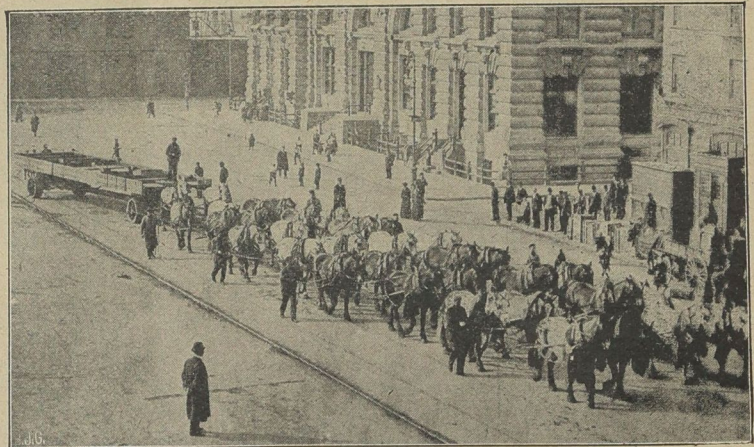
Transport eines Riesenträgers durch die Straßen Berlins.
