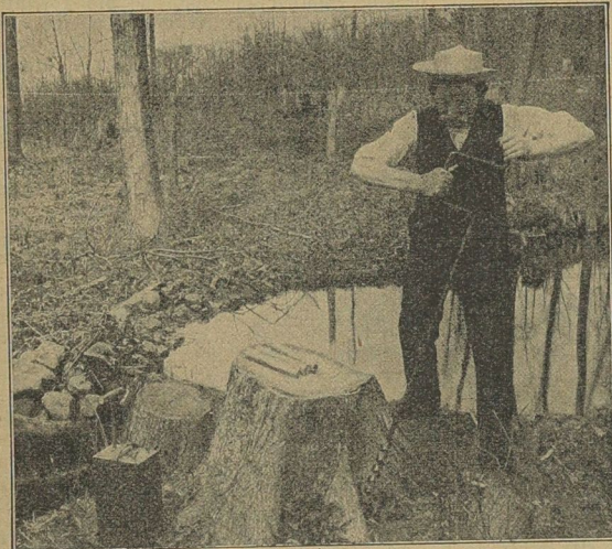
Das Bohren der Sprenglöcher unter auszubrodende Baumstümpfe.
