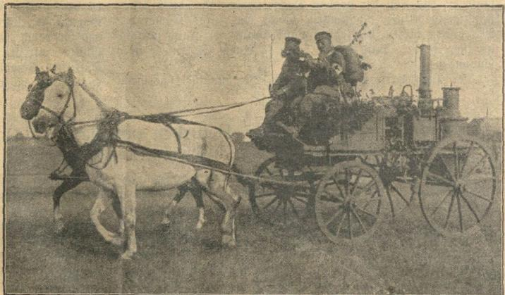
Ein Wagen der deutschen Sanitätskolonne, der mit einem Apparat zum Destillieren des Wassers ausgerüstet ist.
