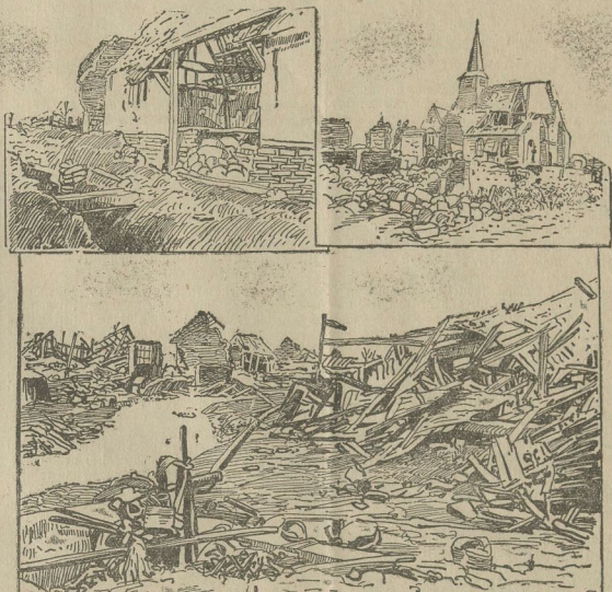
1. Das zerstörte Mamez. 2. Zerstörte Häuser in Mamez. 3. Kirchentürme von Bequincourt.
