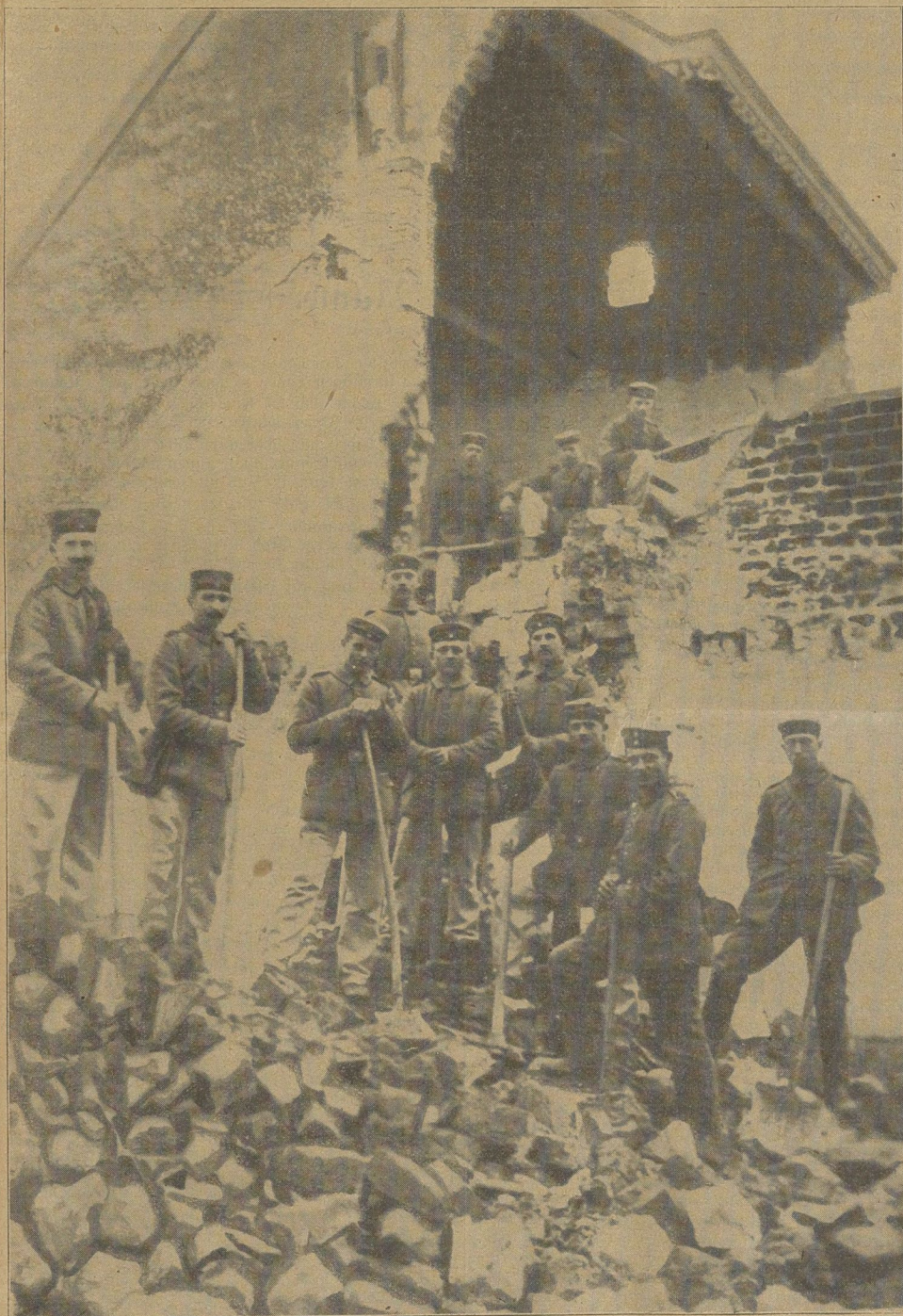
Unsere Schipper beim Instandsetzen französischer Hausruinen.
