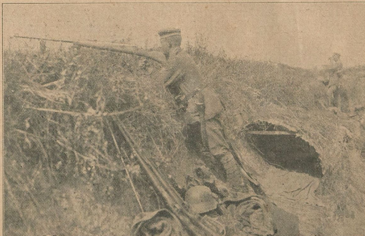
Von der Abwehrschlacht im Westen.
