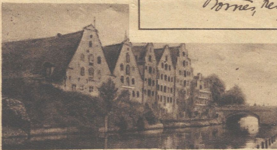
Photothek Die Lübecker Salzspeicher am Hoffentor, ein altes Wahrzeichen Lübecks, sind in ihrem Bestande gefährdet. Jetzt ist wenigstens der erste wiederhergestellt worden
