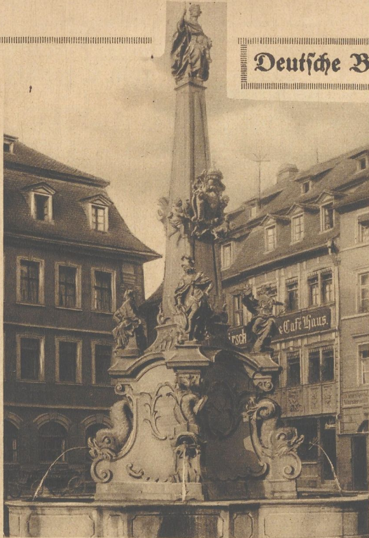
Der im Jahre 1766 aus Sandstein hergestellte Würzburger Bier-Möhlen-Brunnen ist der schönste unter den 65 Brunnen Würzburgs. Aus künstlerischen Gründen wurde bei der letzten Erneuerung der Dianstrich entfernt, was leider die Verwitterung des Sandsteins beschleunigte. Würzburg beabsichtigt für die Erhaltung des Kulturdenkmals Reichszuläufe zu beantragen. Phot. A. Gumbermann, Würzburg
