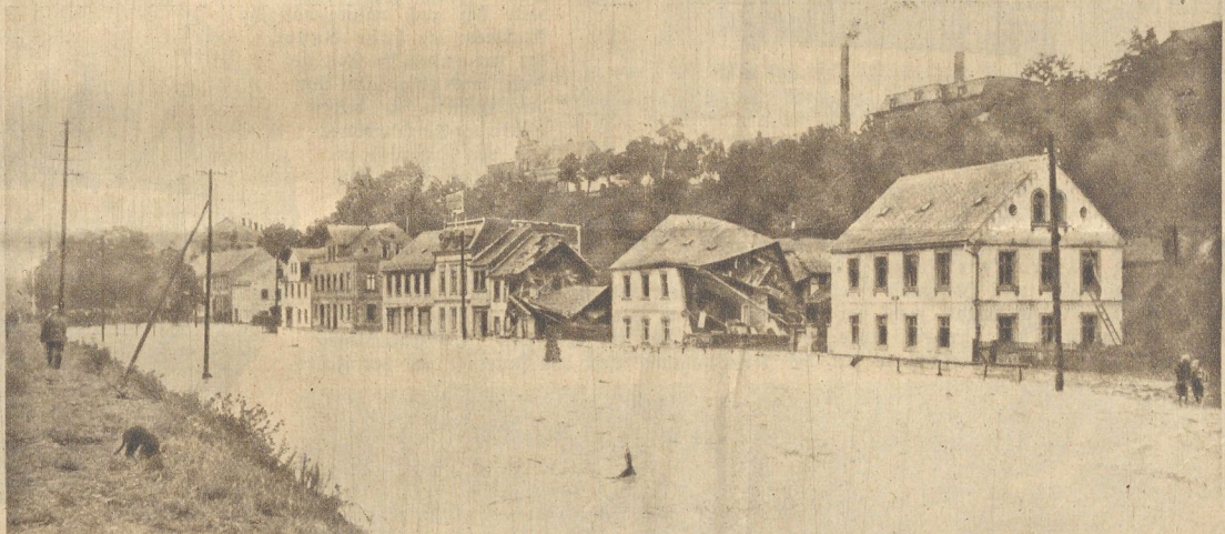
Die durch Hochwasser in Triebes (Neuh) gefährdeten Stadtteile. Im Vordergrund bereits eingesunkene Häuser Phot. B. Schumann, Triebes
