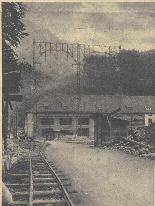
Turbinenhaus von der Chaussee aus mit den riesigen Ableitungsmasten (im Hintergrund der Herzogstand)
