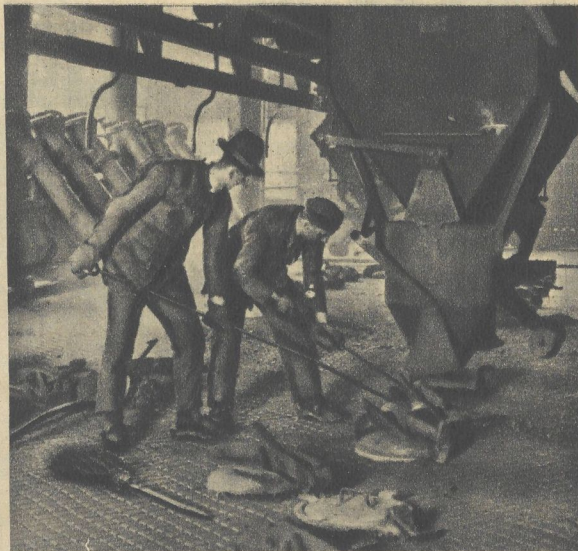
Nothelfer werden bei einem durch den Streik stillgelegten Gaswerk eingeseht
