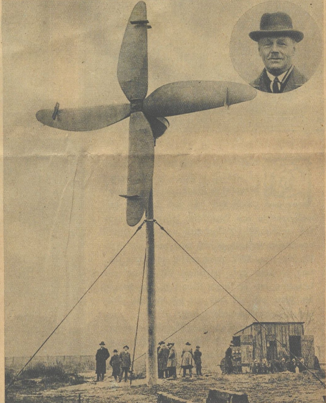
In dem obensiehend abgebildeten Aerodynamo ist von dem deutschen Major Bilau (im Kreise) eine Erfindung gemacht worden, die vielleicht dem Motorschiff Flettner , der sich übrigens mit demselben Problem auch schon beschäftigt hat, an die Seite gestellt werden kann. Der Luftmotor kann innerhalb von 8 Stunden aufgestellt werden. Der vierflügelige Propeller hat einen Durchmesser von 9 Metern. Die Stromerzeugende Dynamomaschine ist in einem tropfenförmigen Hohlkörper eingebaut, der auf dem Tragmast ruht. Die Anlage arbeitet schon bei geringen Windstärken und liefert eine Strommenge, die sie vor allem für landwirtschaftliche und gewerbliche Betriebe überall ausnützlich macht.
