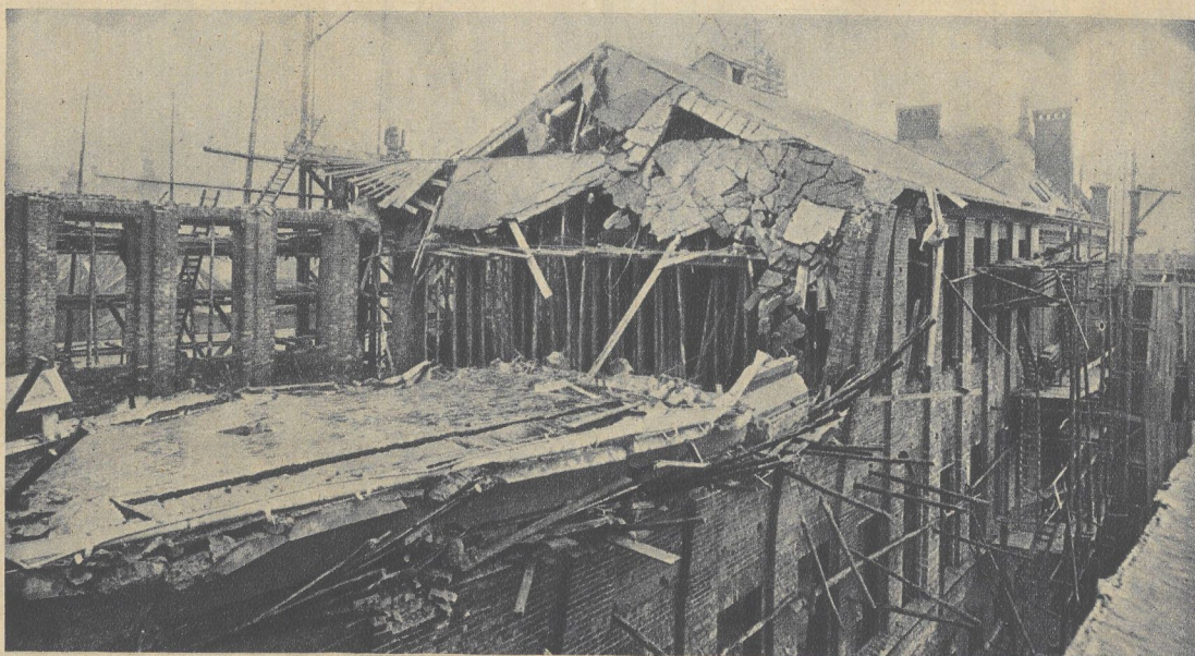
Der Neubau des Telegraphenamtes in Hagen (Westf.) stürzte ein
