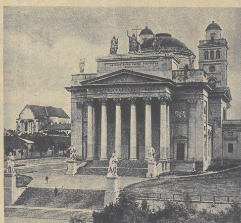
Der berühmte Dom in Eszterháza (Ungarn) wurde vor kurzem durch ein heftiges Erdbeben vollkommen zerstört Sennede
