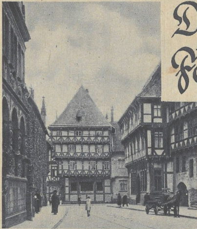
Fachwerkhäuser in Halberstadt
