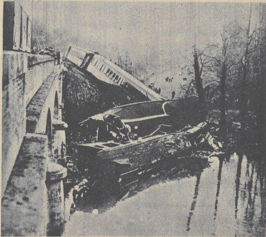
Ein furchtbares Eisenbahnunglück ereignete sich jüngst auf der französischen Strecke Bordeaux-Paris. Die Wagen des entgleitenen Exprezuges führten zum Teil die Böschung hinab. Atlantik
