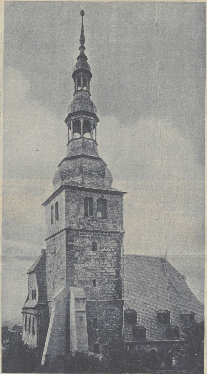
Ein dem Verfall geweihtes Wahrzeichen Thüringens in der Nähe des Kuffhäusers ist die oben abgebildete Oberkirche in Frankenhäusern, deren Turm niedergelegt werden muß. Ein Brand im Jahre 1759 zerführte die Bindkraft des Mörtels, so daß sich an dem bereits 1381 erbauten Turm starke Risse zeigten. Die schöne, alte Kirche bedrohte die Umwohnenden bereits lange durch die Einsturzgefahr. Sie wird aber hoffentlich bald nach der Niederlegung wieder hergestellt werden. Phot. H. Plog
