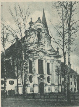
Dieben am Ammersee: Westfassade der Klosterkirche (Barock)
