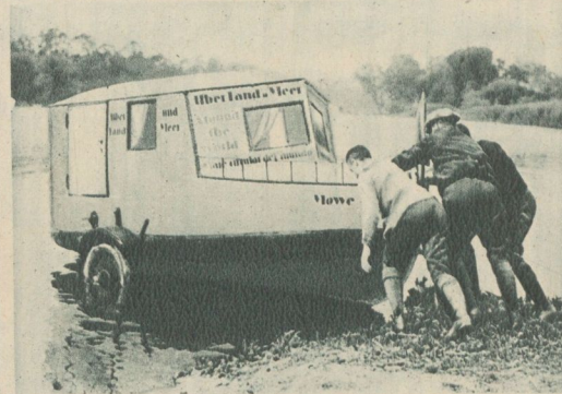
Ein Motorboot, das zugleich als Land- und Wasserfahrzeug dienen kann, wurde neuerdings erbaut. Das Motorrad, das die „Möbe“ auf dem Lande zieht, wird für Wasserfahrten abgenommen und im Innern des Bootes verladen Phot. Groß
