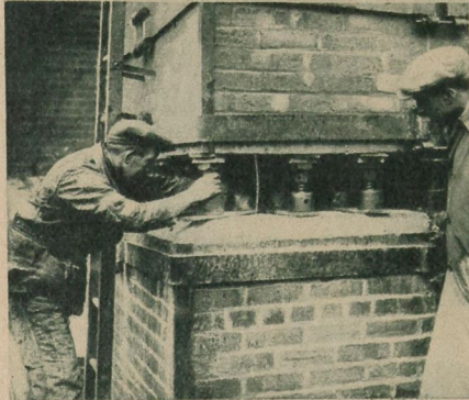
Die Ausbesserung an einem Schornstein in England wurde dadurch ermöglicht, daß der Schornstein an der betreffenden Stelle künstlich gestützt wurde. So konnten die schadhaften Steine durch neue ersetzt werden. Glabophot
